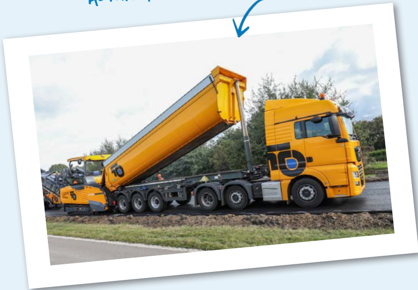
Asfaltspreidmachine en vrachtwagen
