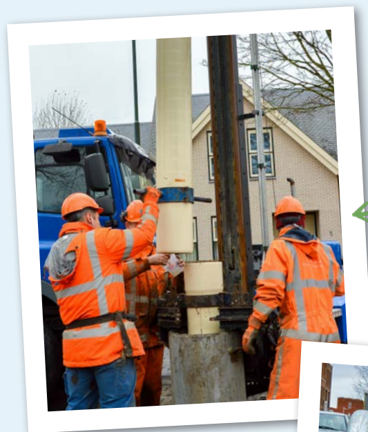
Filterbuis en blinde buis plaatsen
