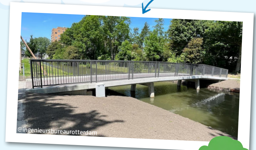
Brug van cementloos beton in Hoogvliet
