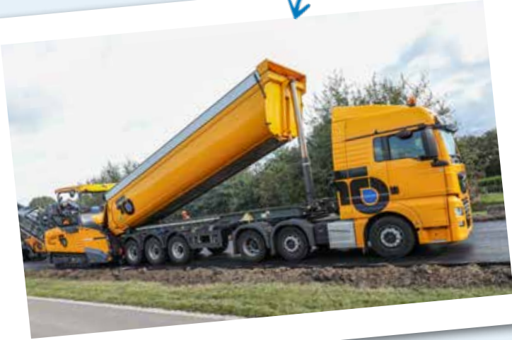
Asfaltspreidmachine en vrachtwagen
